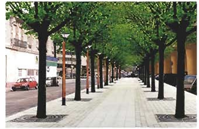
MISE EN PLACE DU NOUVEL AMÉNAGEMENT
